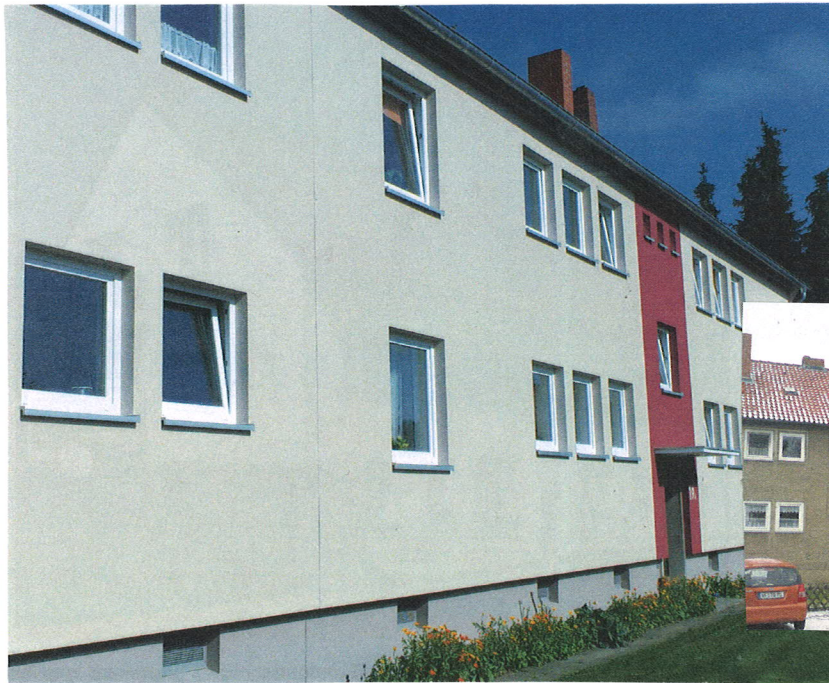
Abb. 1: Die weiß verputzten Gebäude heben sich angenehm aus der Nachbarschaft heraus.
