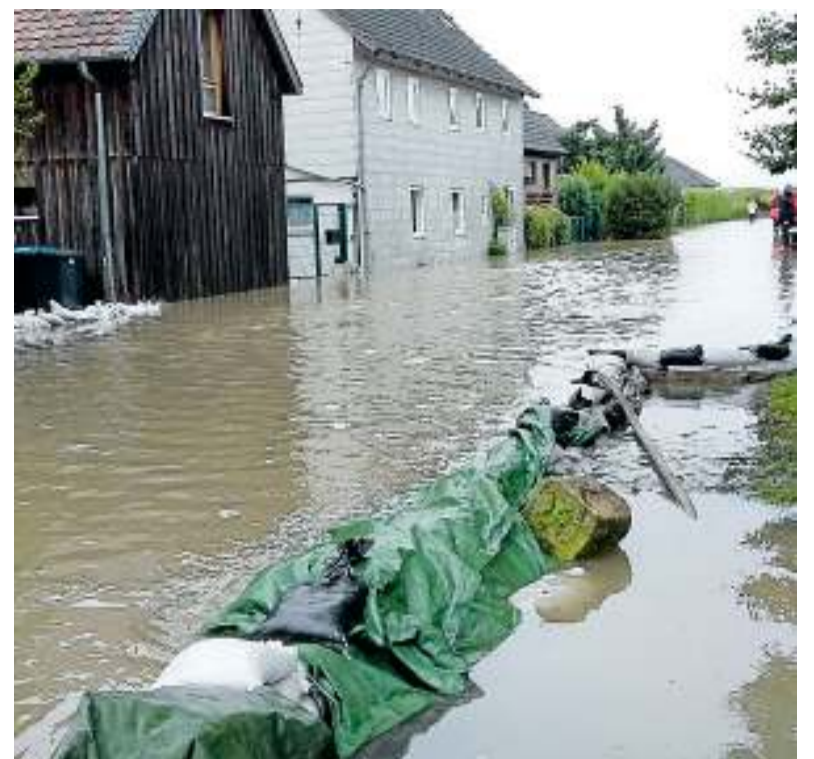
Die Oker-Flut hat auch Sickinge stark in Mitleidenschaft gezogen. Auf dem Bild ist der überschwemmte Sattlerweg zu sehen.
